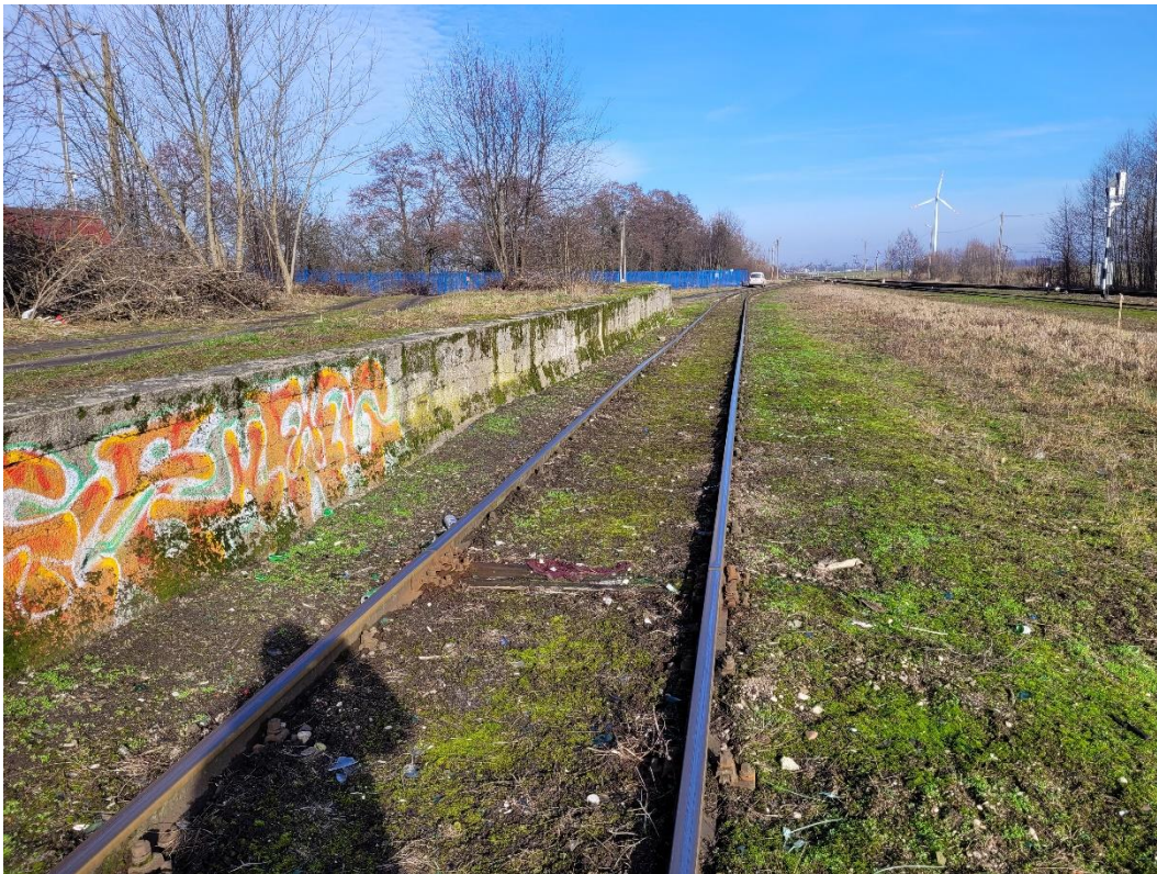
Zdjęcie 7 l.p.o. Rypin, rampa ładunkowa
