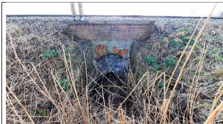
Fot. 52,066-1. Widok na wlot do przepustu. Brak balustrady na ścianie czołowej. Liczne ubytki cegieł i spoin.
