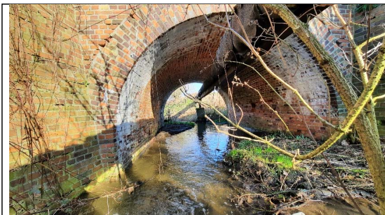
Fot. 40,250-3. Widok na część przelotową. Widoczne liczne przecieki, ubytki spoin i cegieł.
