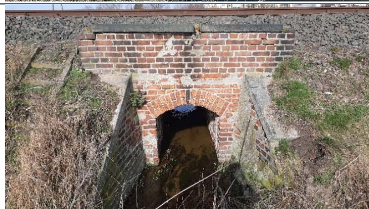
Fot. 52,214-2. Widok na wylot z przepustu. Brak balustrady na ścianie czołowej. Liczne ubytki spoin i cegieł.
