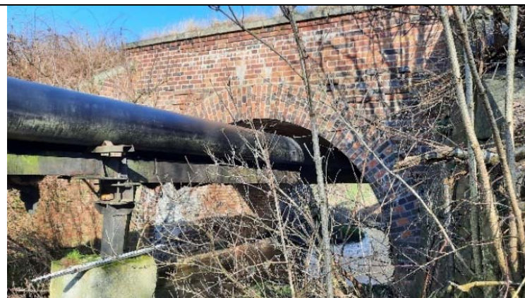
Fot. 40,250-1. Widok na obiekt od strony górnej wody. Widoczna konstrukcja wsporcza dla przeprowadzenia sieci. Brak balustrady na ścianie czołowej.
