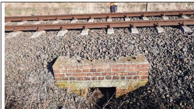
Fot. 40,549-1. Widok na wlot do przepustu. Brak balustrady na ścianie czołowej.
