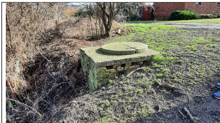
Fot. 51,180-3. Widok studnie na wylocie. Widoczne ubytki cegieł. Korozja biologiczna.
