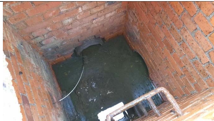
Fot. 51,1802. Widok na wylot z przepustu. Przepust zakończony ceglana studnią. Studnia drożna.
