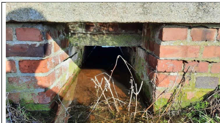
Fot. 43,990-3. Widok na część przelotową. Przepust drożny. Widoczne ubytki spoin.
