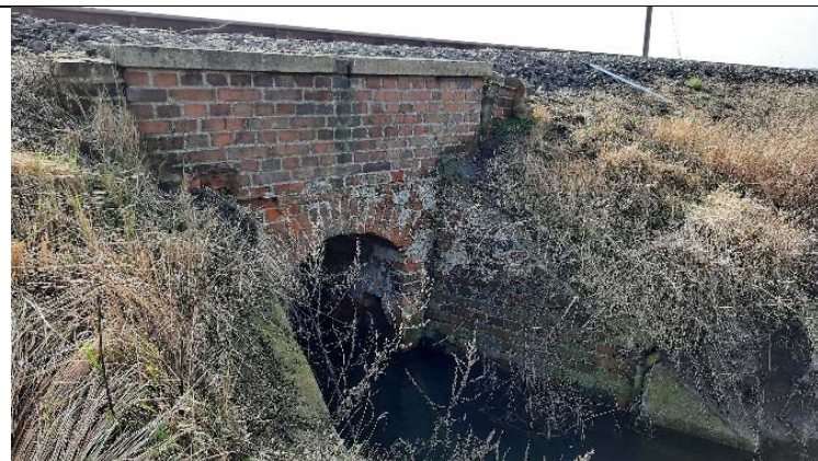
Fot. 52,214-1. Widok na wlot do przepustu. Brak balustrady na ścianie czołowej. Liczne ubytki spoin i cegieł.
