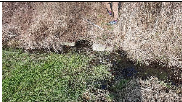
Fot. 51,180-1. Widok na wlot do przepustu. Przepust prawie całkowicie zalany. Ściana czołowa całkowicie zrosnięta roślinnością.
